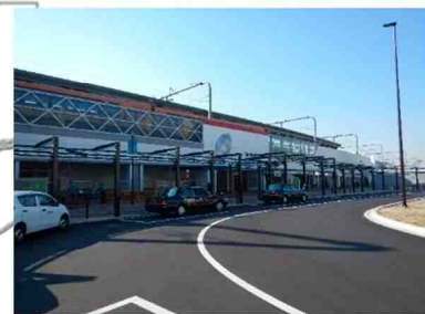
◆整備例（東花園駅前交通広場）
