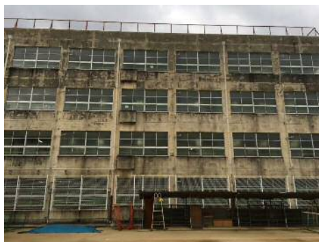
外壁改修 施行前
