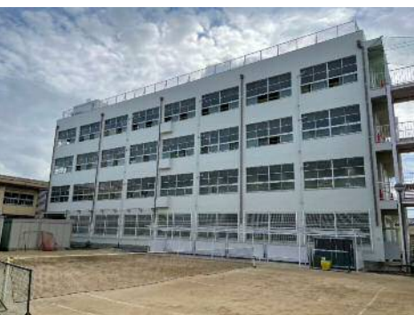
外壁改修 施行後
